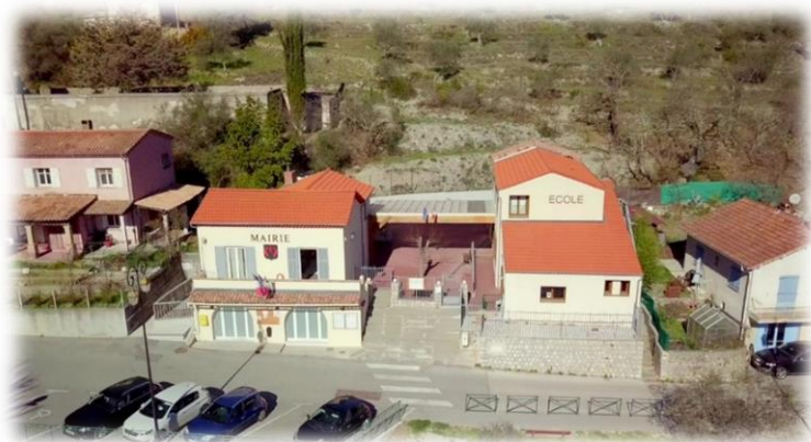
Figure 3 Rénovation et agrandissement de l'école de Pierrefeu
